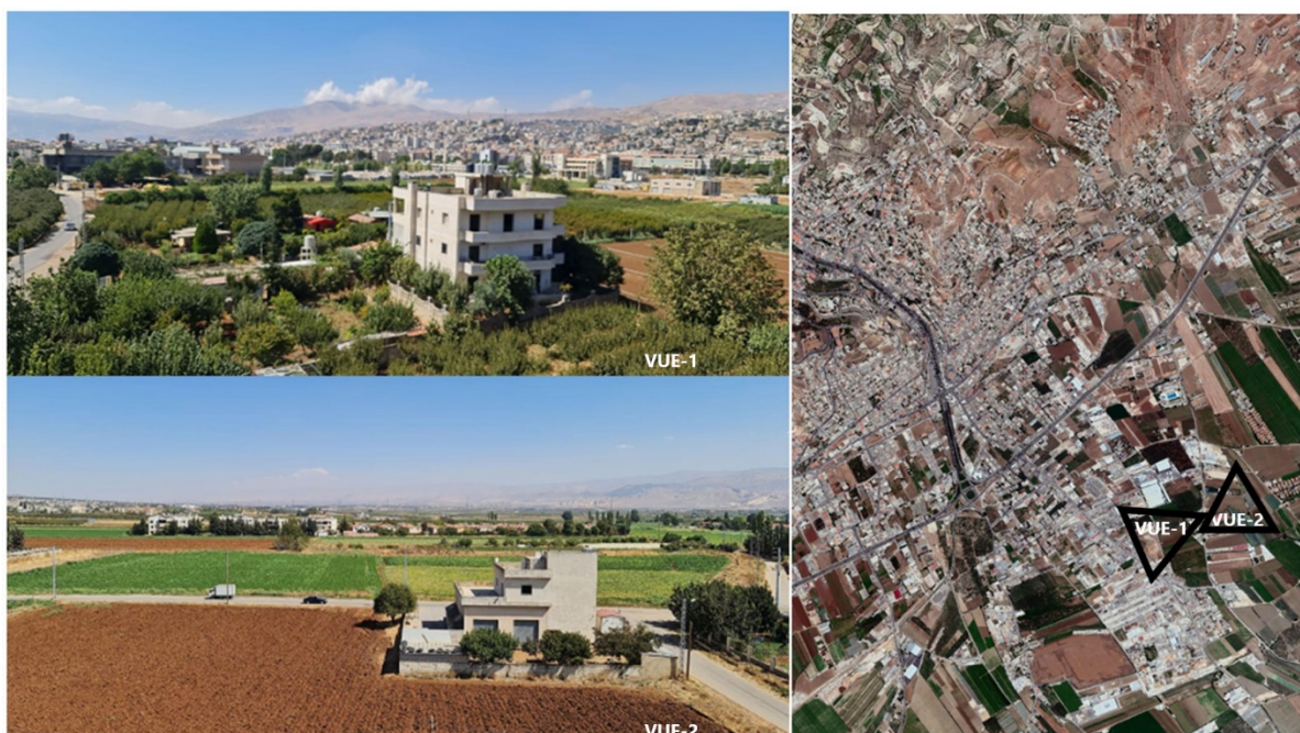
Figure 1 : construction dans les terrains agricoles.
